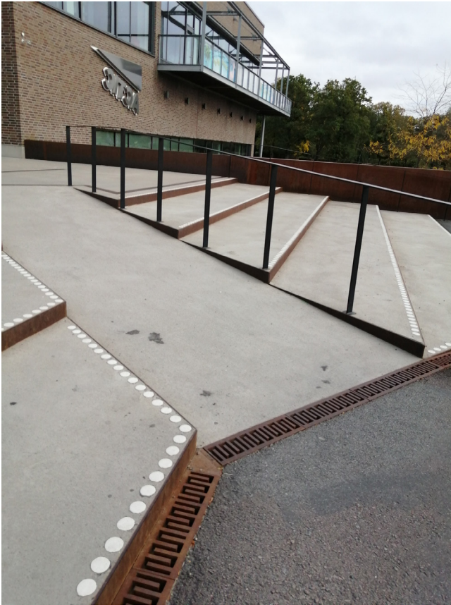
Entré/Ramp. Vid entrén till Munktelbadet i Eskilstuna har trapporna och rampen försetts med led-belysning och självlysande färgmarkering som också är taktila.
