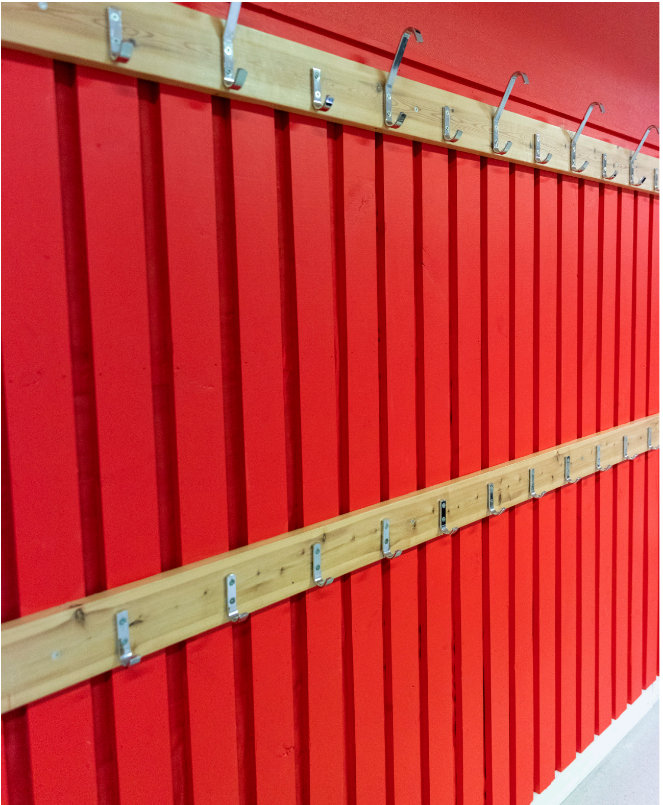
Kontrast. God kontrast mellan golv och väggar hos Friskis och Svettis på Tyresö. Krokar på olika höjd är ett enkelt sätt att göra anläggningen tillgänglig för fler.
