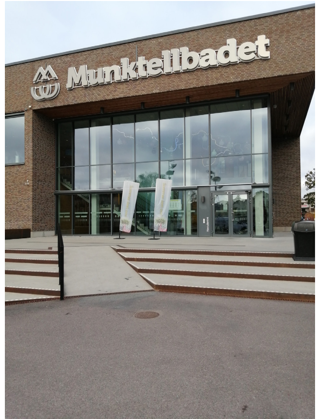
Entré/Ramp. Vid entrén till Munktelbadet i Eskilstuna har trapporna och rampen försetts med led-belysning och självlysande färgmarkering som också är taktila.
