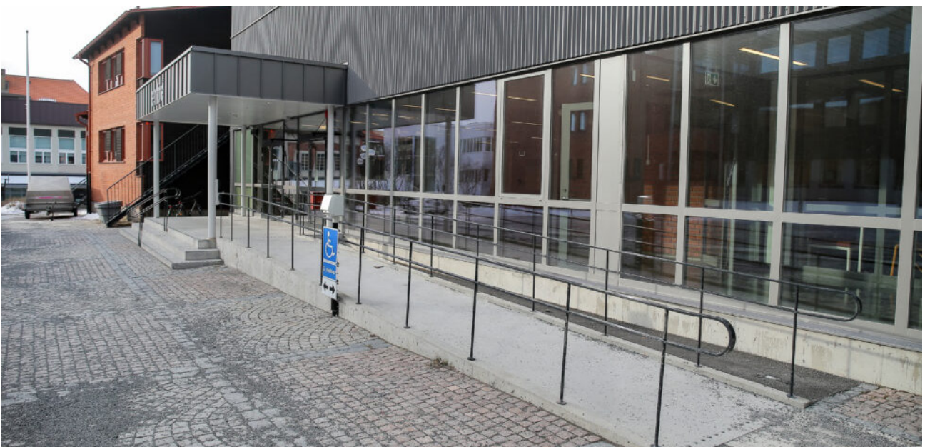
Ramp. Infartsrampen till Sporthallen i Östersund är utsträckt längs husväggen och ger en flack lutning. Rampen är också försedd med ordentliga ledstänger.
