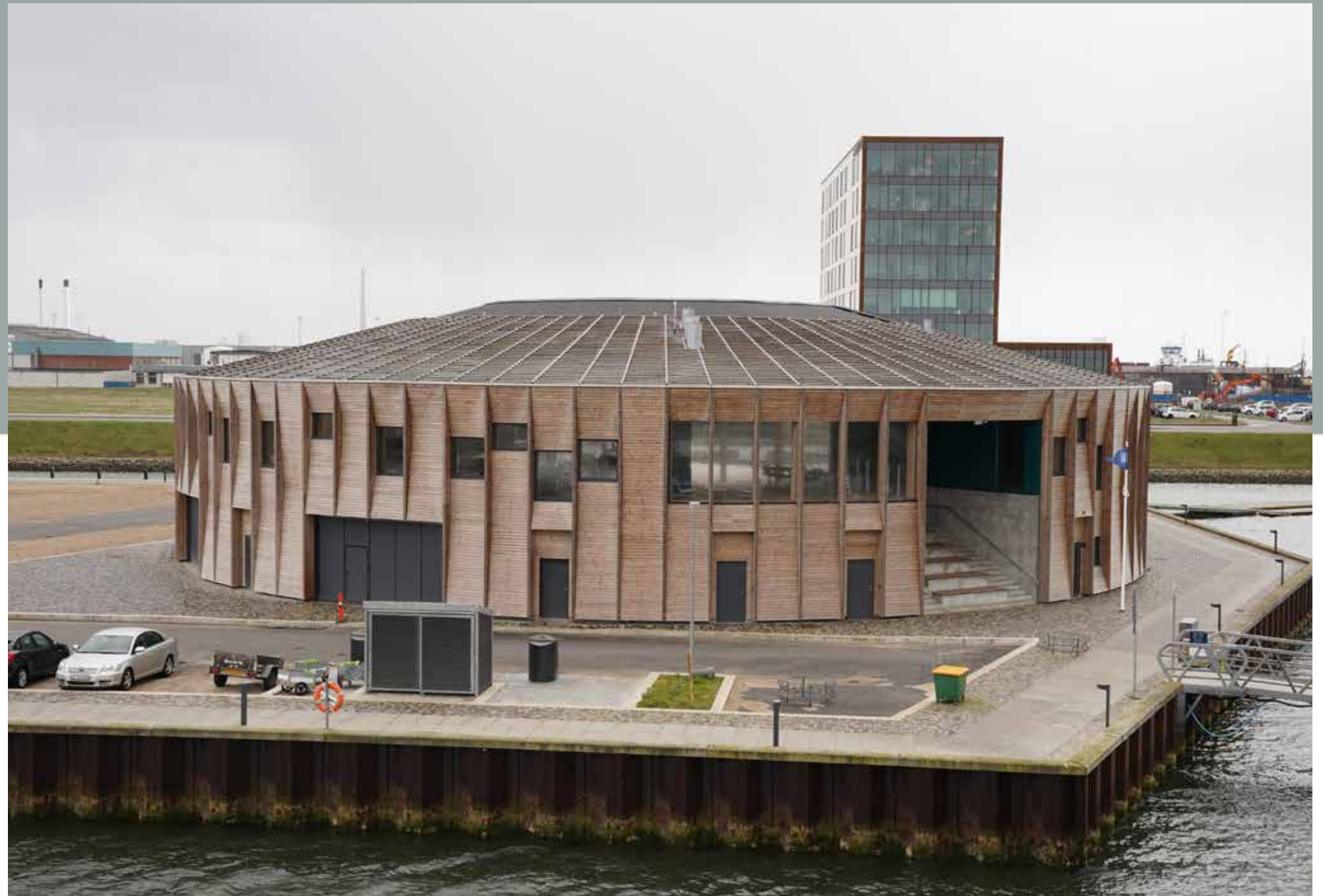
Det maritima centret har fått stor uppmärksamhet för sin fina arkitektur och goda planering. (Arkitekt: Snøhetta)
