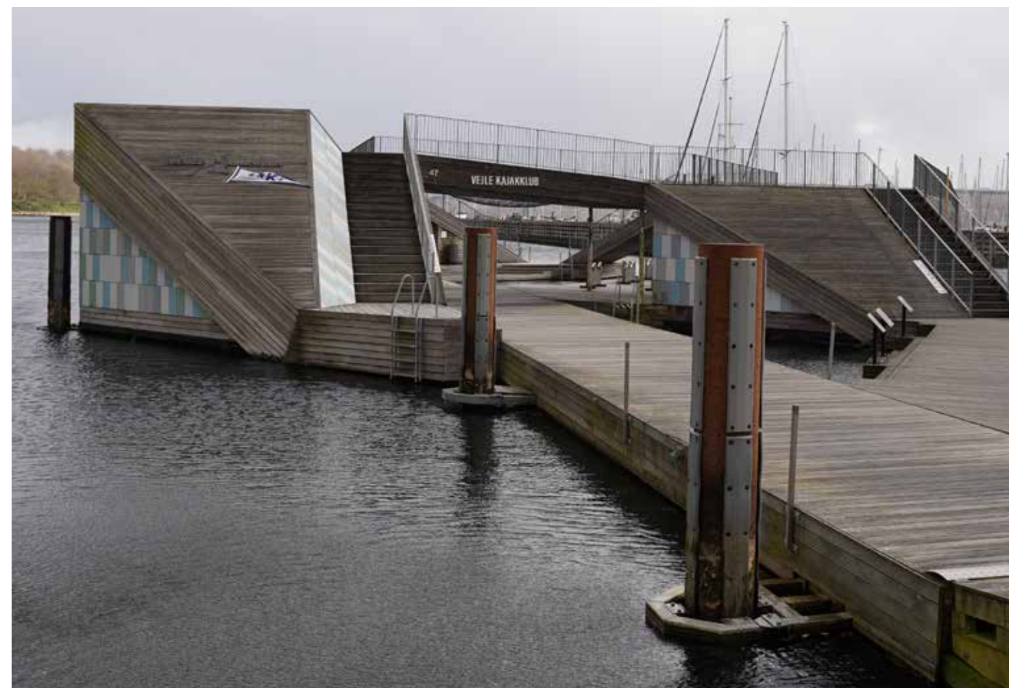
Konstruktionen är fäst mot ett antal rejäla pålar i botten. Möjliggör flytbryggans anpassning till vattenytan.
