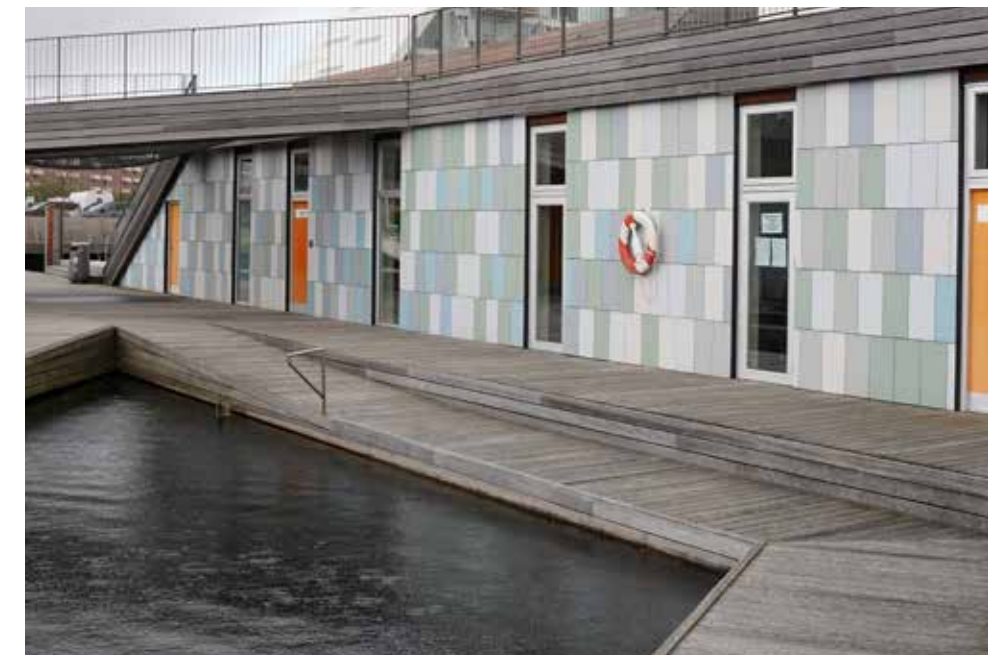
Inre bassäng i mitten av anläggningen har anpassade kanter för bra nedstigning i kanoter.
