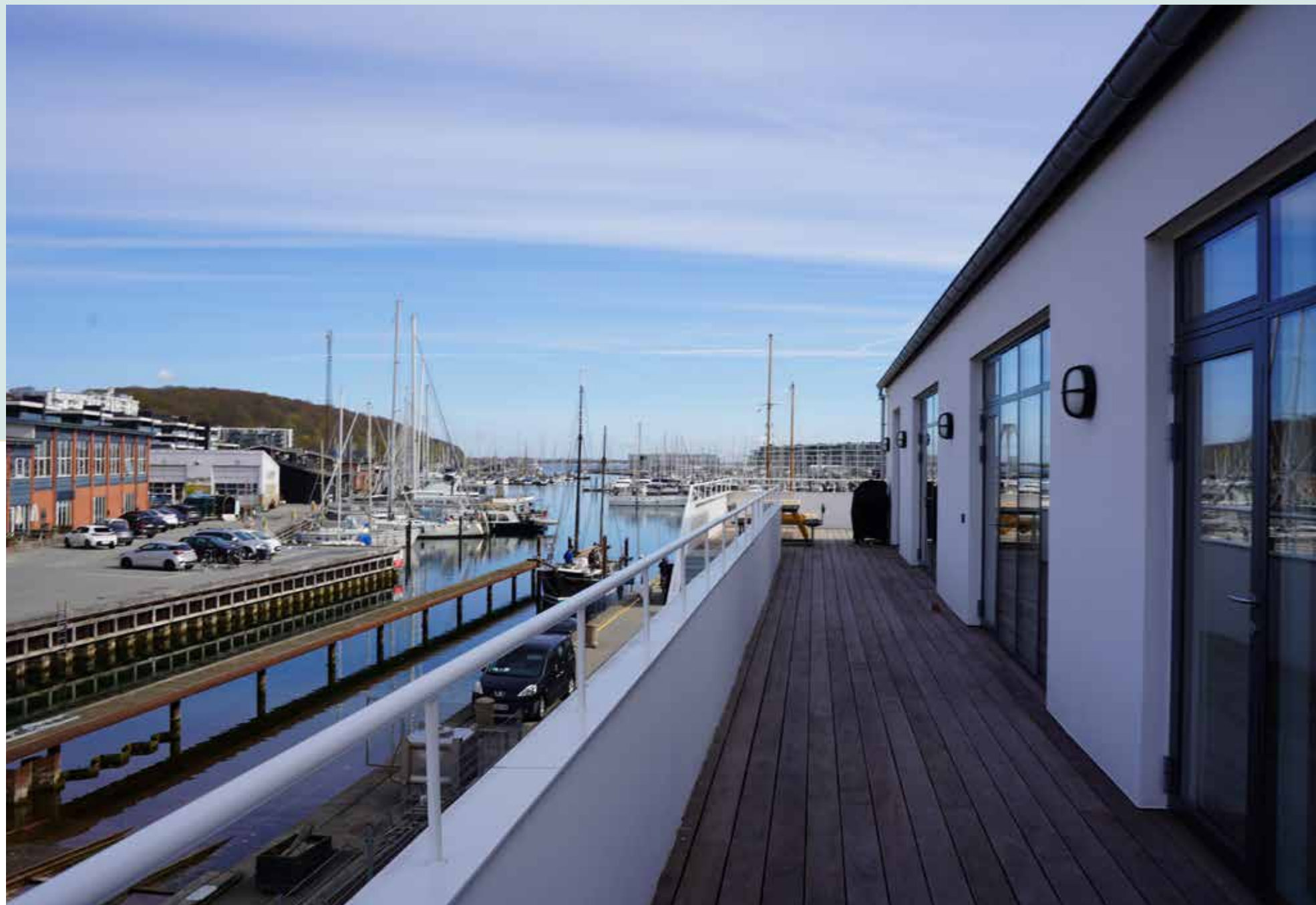
En altan som löper runt hela byggnaden gör att det alltid finns sol, skugga och lä. De stora fönsterpartierna skapar ljus och transparens.
