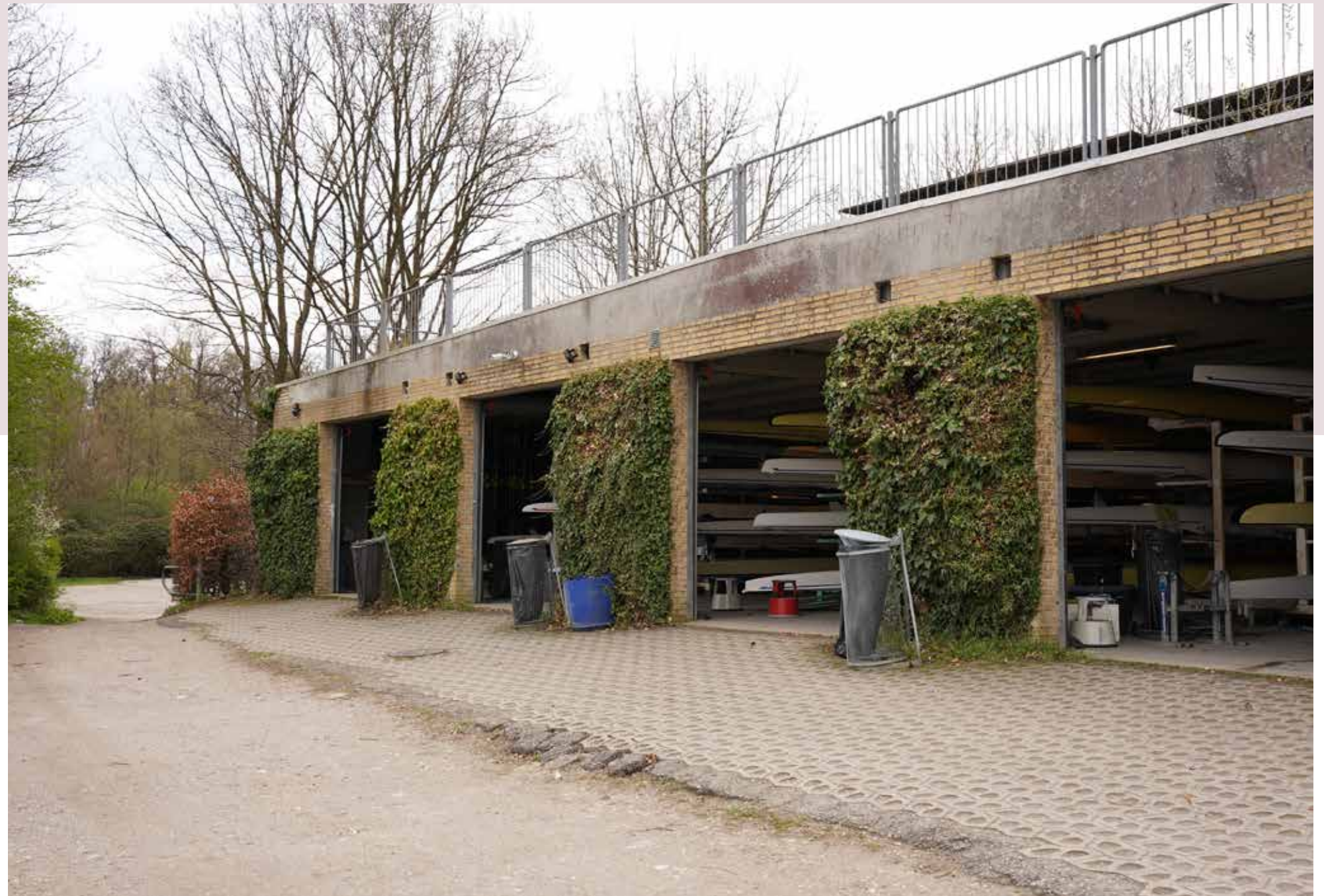
Portar till den stora båthallen. Direkt ner mot vattnet.
