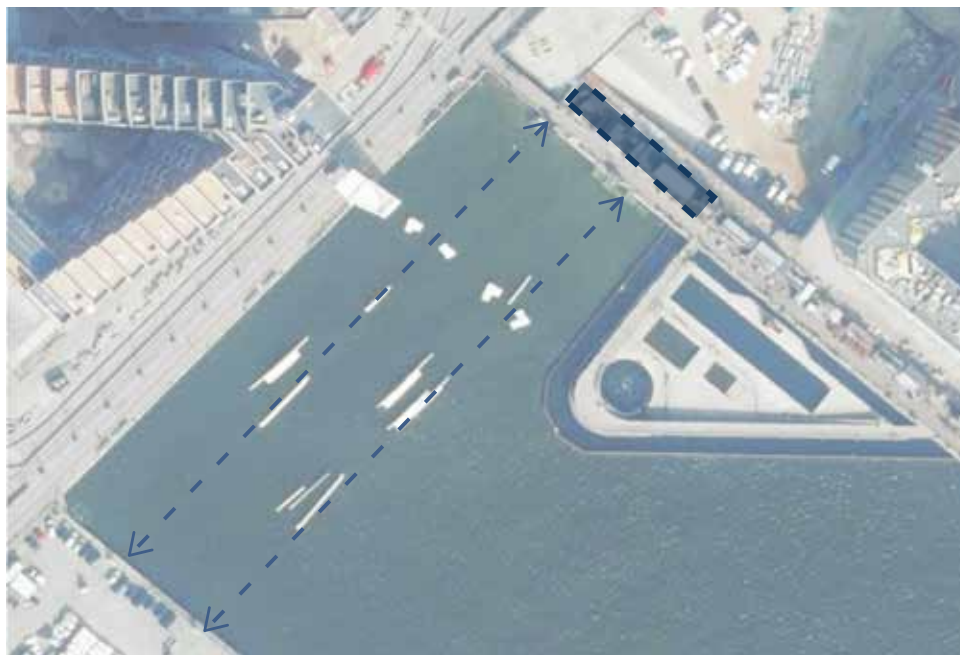
Två kabelbanor sträcker sig över den centrala hamnbassängen.
